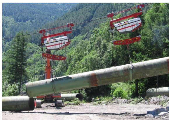
Рис.4. Траверсы для перемещения труб.
