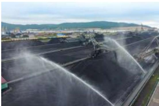
*Рис. 3. Стационарная система орошения*
