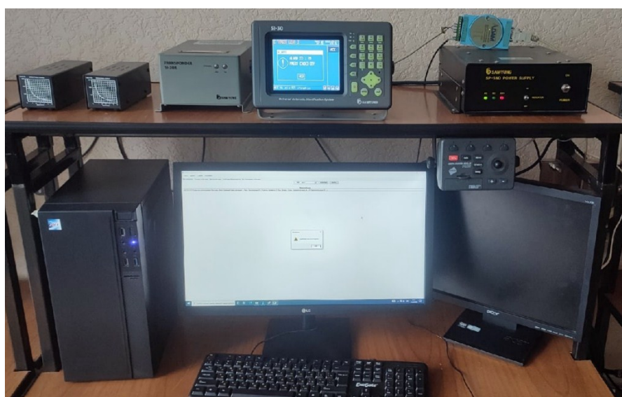
Рисунок 4 - Приёмная станция АИС
