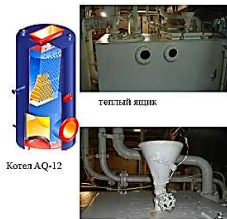
Место ввода суспензии ремонтного состава
