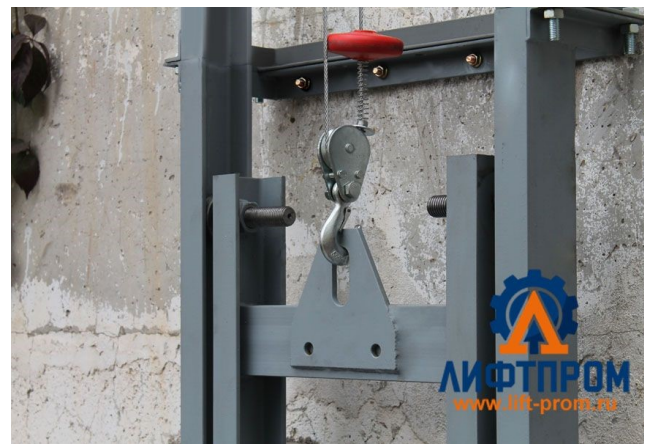
Рисунок 4: а) К расчету нагрузочной способности Нижегородской причальной стенки б) Пример крепления к бетонной стене направляющих подъемника
