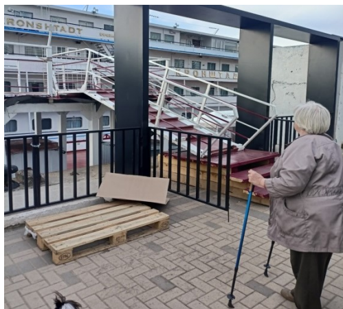
Рисунок 1 – Причал № 8, г. Нижний Новгород, сварная лестница с выходом на поддон
