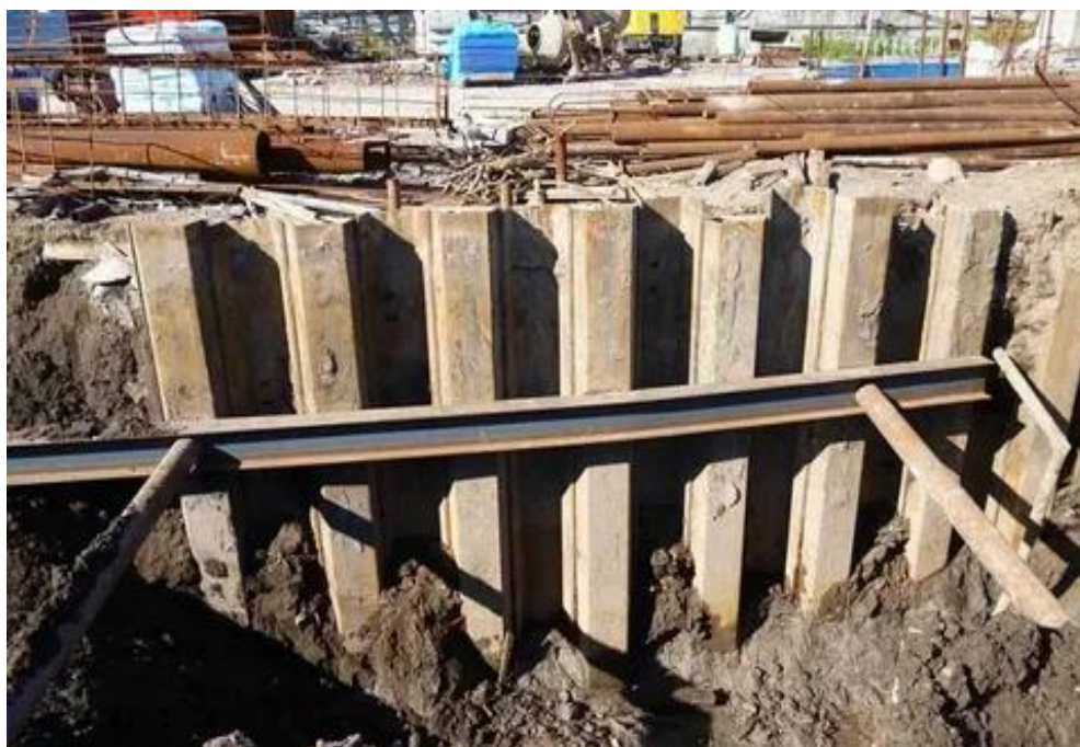
Рисунок 7 – Применение шпунта Ларсена 4
