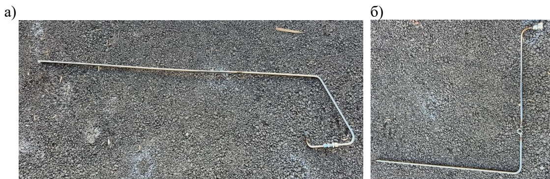
Рисунок 2 – Две секции топливного трубопровода для подачи аммиака: а – секция 1; б – секция 2
