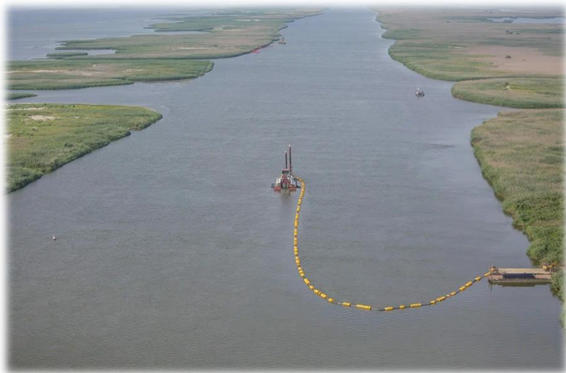
Рисунок 2 – Дноуглубление на морской части, защищенной островками
